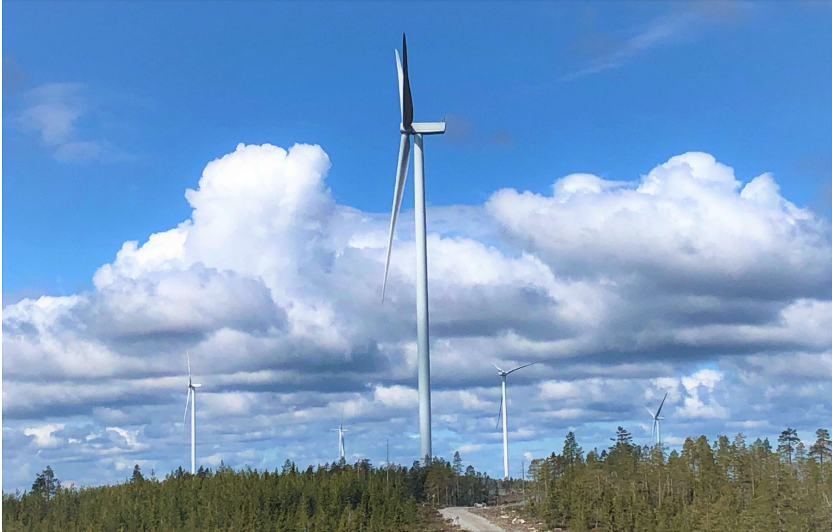
Veduta dell'impianto eolico di Brattmyrliden in Svezia di proprietà di Falck Renewables
